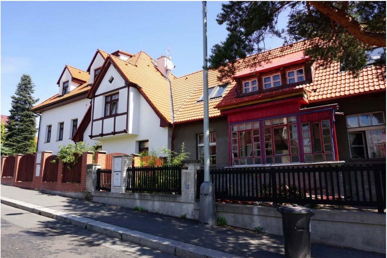
Obrázek 4.2: Zachovalý původní styl domů kolonie Domov i novodobá úprava.
