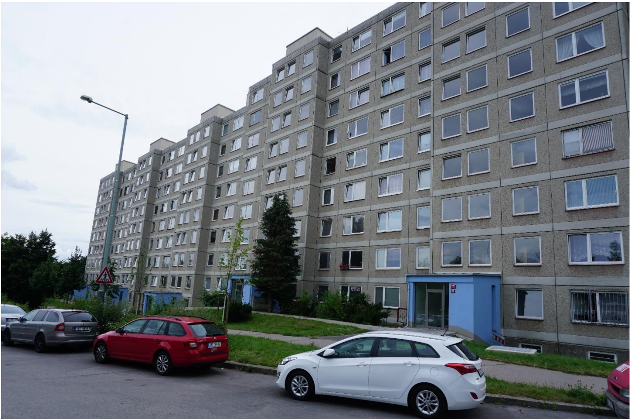
Obrázek 15.3: Černý Most II – panelové domy v ulici Bobkova.
